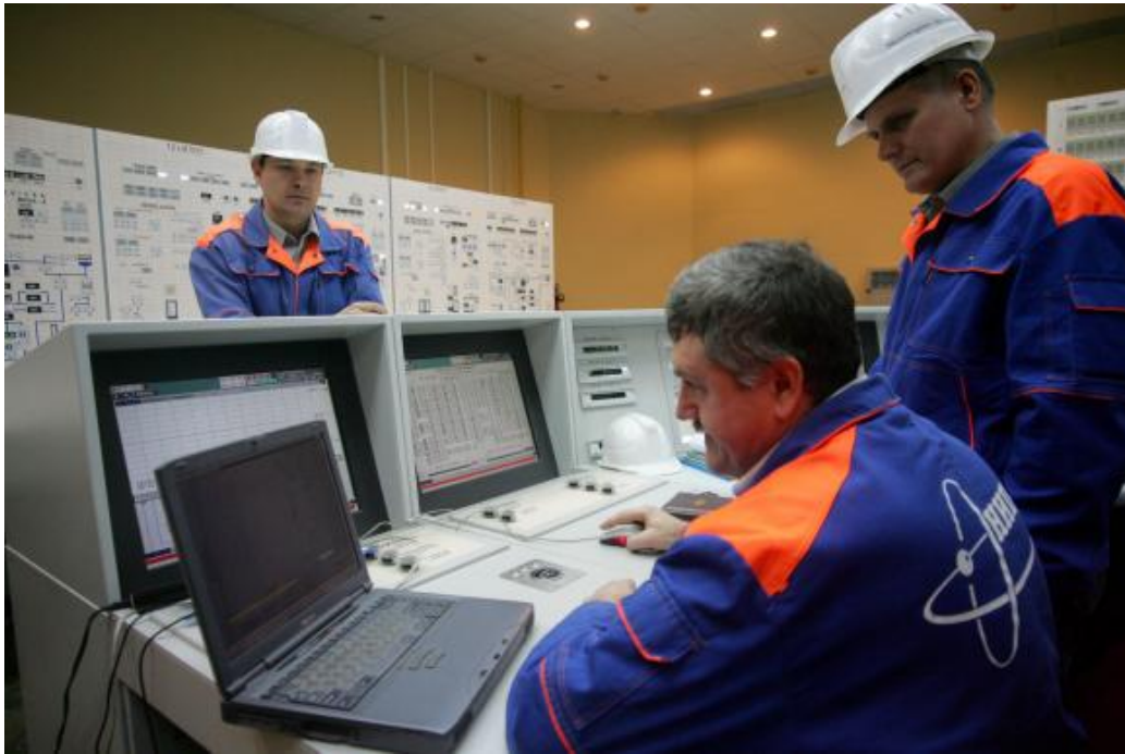
Abbildung 3: Russischer Techniker im iranischen Kernkraftwerk Buschehr mit einem Siemens Field PG Notebook (Quelle: http://www.upi.com )
