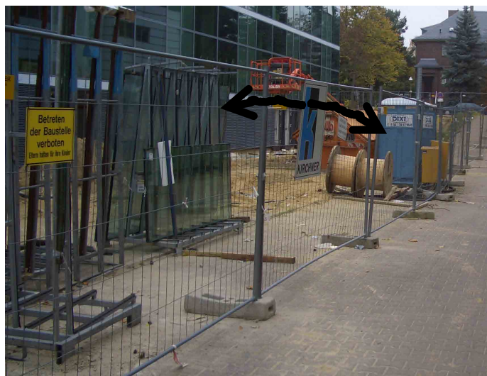
Abbildung 5.2: Schwankung der Zaunelemente
