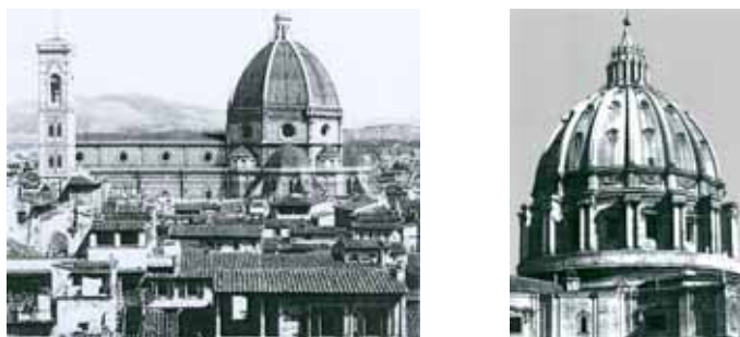
Abb. 3 Beispiele sakraler Bauten, deren Kuppel eine Halbeifläche ist. links: Dom in Florenz, rechts: Basilika des Heiligen St. Peter in Rom.
